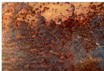
大气尘埃 / 铁锈 / 管道剥落物
